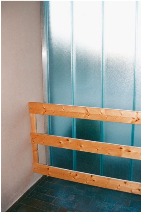
Abb. 8 Abschirmung einer Wand aus Profilbauglas
