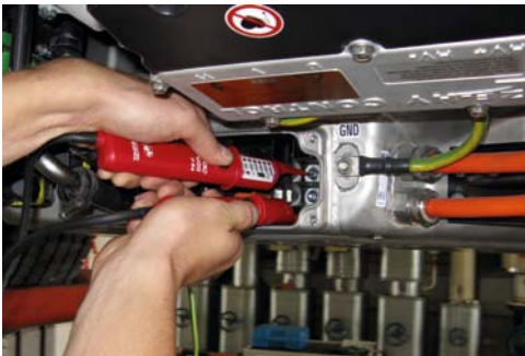
Bild 3: Spannungsfreiheit feststellen
