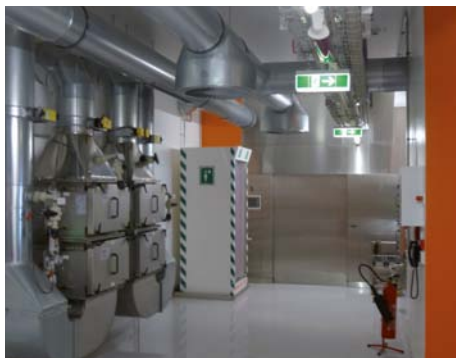
Abb. 4 Bau für S3-Experimente
